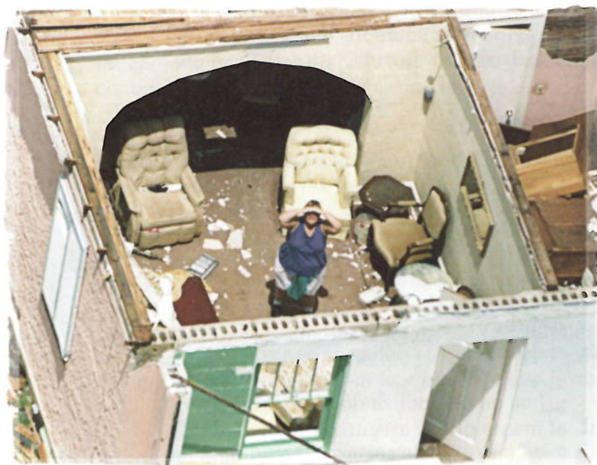
Una casa destruida por un huracán en Florida
